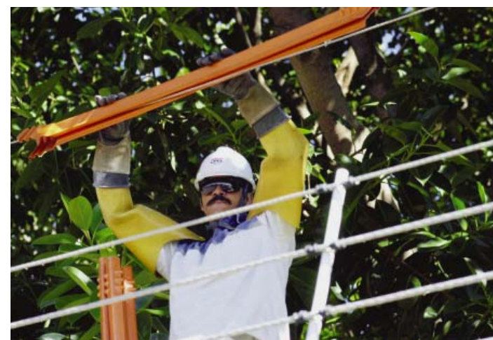
Manta e calha isoladas. Detalhe da colocação da calha isolada.
